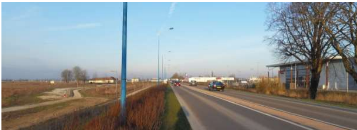
Vue vers la zone commerciale de la Belle Idée et les terrains de l'aérodrome
