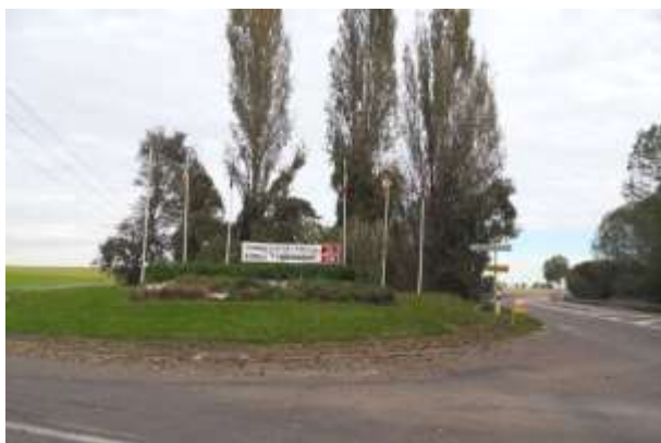
Aménagement du croisement RD164/RD619
