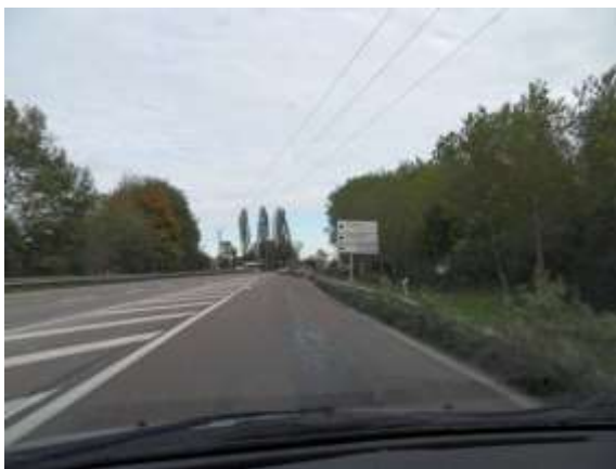
1. L'aménagement de la voirie traduit le croisement entre la RD619 et la RD164. Les trois peupliers marquent le carrefour.
