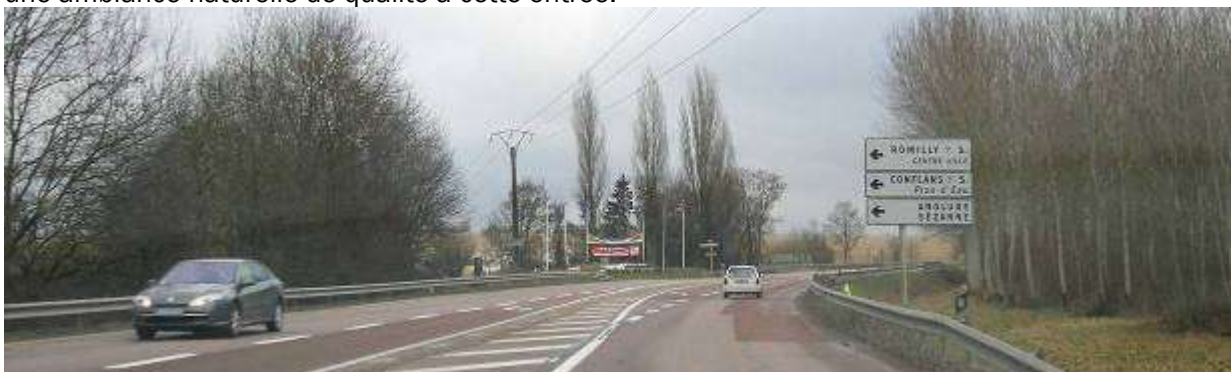
Vue depuis la RD 619 sur le croisement avec la RD164
