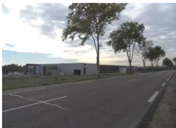
Bâtiment en construction dans la zone industrielle
